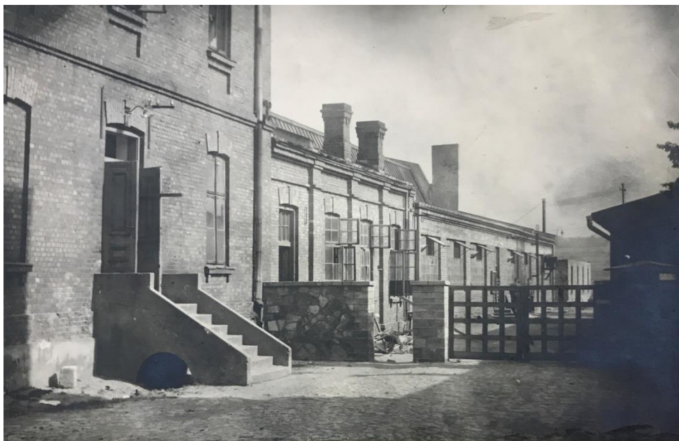
Fot. Widok hali warsztatowej ukończonej w 1938 r. i wjazd na podwórze Szkoły.
