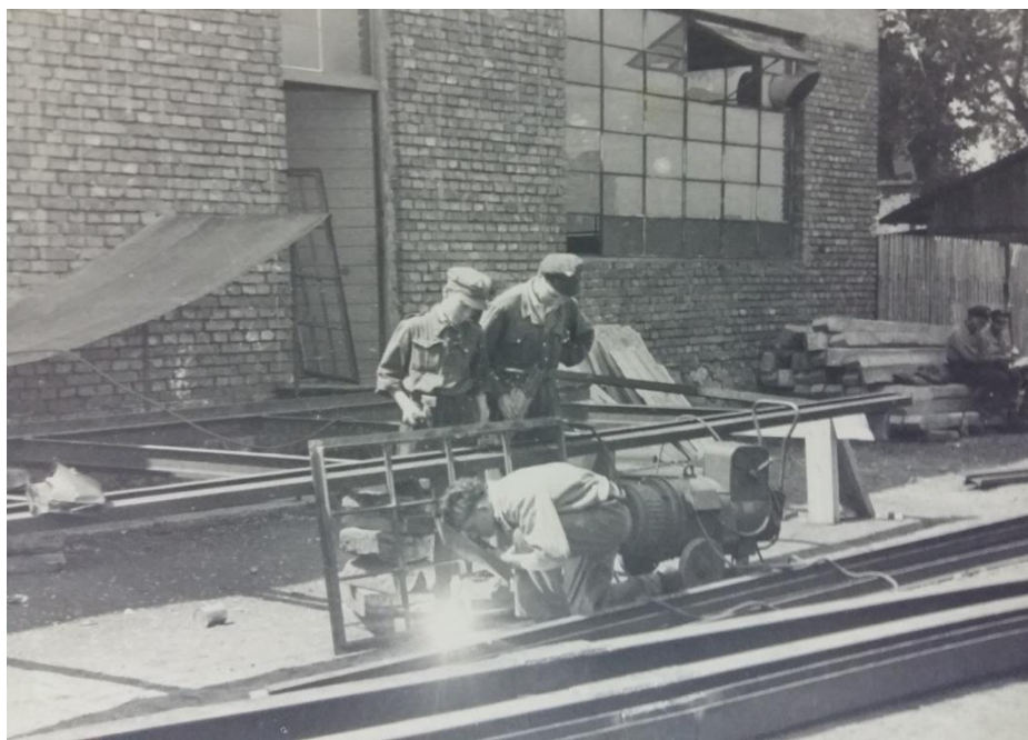
Fot. Spawanie części konstrukcji stalowej w Szkole. Rok 1948.
